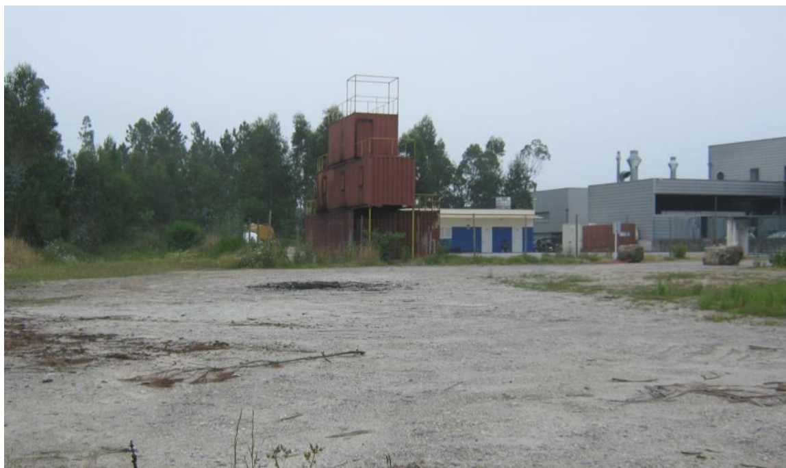
Figura 2 - Local para o Estaleiro
